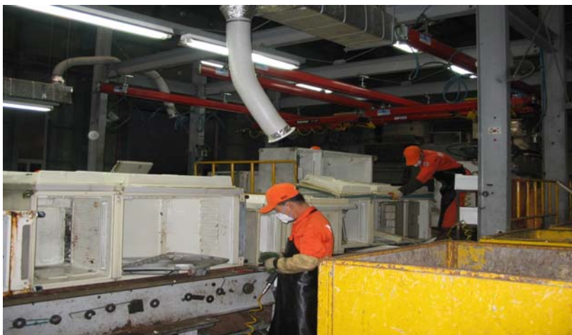
Instalación de reciclado de frigoríficos en el Japón
